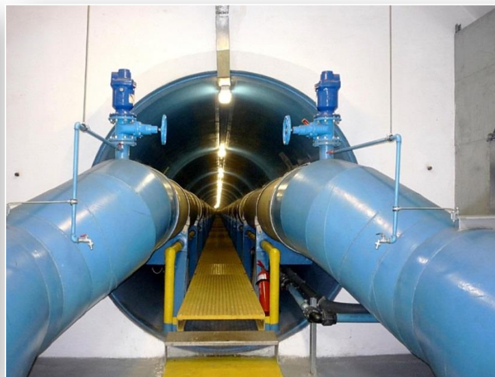
Wejście do tunelu pod Wisłą
